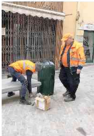
I lavori in via Monferrato
